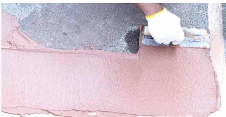
仕上りの厚みは1~2mm程度です。見た目の美しさを重視する場合はコテを立てて、できるだけ材料を薄くするように引っ張ります。厚みがあるほどコテの跡が残りやすくなります。厚みがある方が表面に凹凸ができやすいので滑り止め効果は高くなります。より滑り止め効果を高くする場合は、粗面に仕上げるように心がけましょう。
